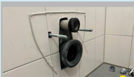
Figuur 3: Neem het toilet van de wand. LET OP: hier kan nog water instaan. Laat de pot leeglopen in een wasbak of onder de douche.
