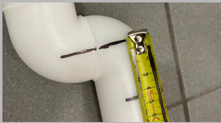
Figuur 13: Meet het verschil tussen beide strepen op beide leidingen.
