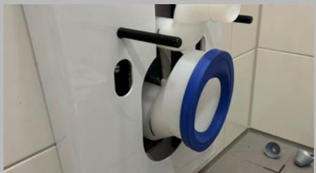
Figuur 15: Vijl de gezaagde kant van de leidingen glad en voorzie deze van wat montagevet. Plaats vervolgens de leidingen terug in de muur.
