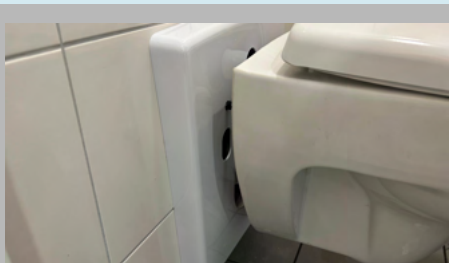
Figuur 17: Zet uw toiletpot recht voor de draagsteunen om vervolgens de pot er rustig op te schuiven.
