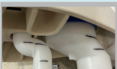
Figuur 12: Haal beide leidingen uit de wand en plaats deze zo ver mogelijk achter in uw toiletpot. Teken op beide leidingen de rand van de pot af.
