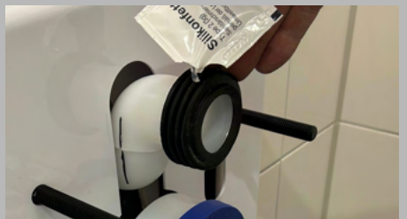
Figuur 16: Vet zowel het rubber op de toevoer als het manchet op de afvoer goed in.
