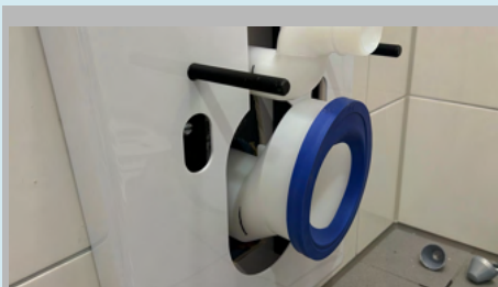
Figuur 10: Teken bij de nieuwe toe- en afvoerbuis af tot waar de afdekkap komt.
