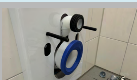
Figuur 11: Plaats de rubberse ring van de oude aanvoerbuis op de nieuwe aanvoerbuis en plaats het manchet op de nieuwe afvoerbuis. Op de ring van het manchet staan een 5 en een 7. Plaats het aantal centimeter waarmee u het toilet wil verhogen naar boven.
