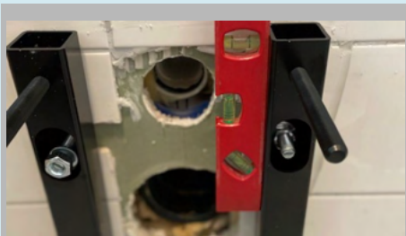
Figuur 7: Hang beide draagsteunen waterpas en draai deze met de ringen en moeren handvast.
